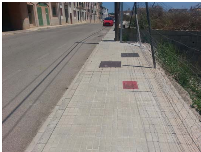
13. Hidrant soterrat de 1 boca de diàmetre ràcord Barcelona 70 en interior d'arqueta vermella però connectat a xarxa de proveïment sense aigua. Cal connexió per part de l'Ajuntament ( no inclòs a aquest projecte)
