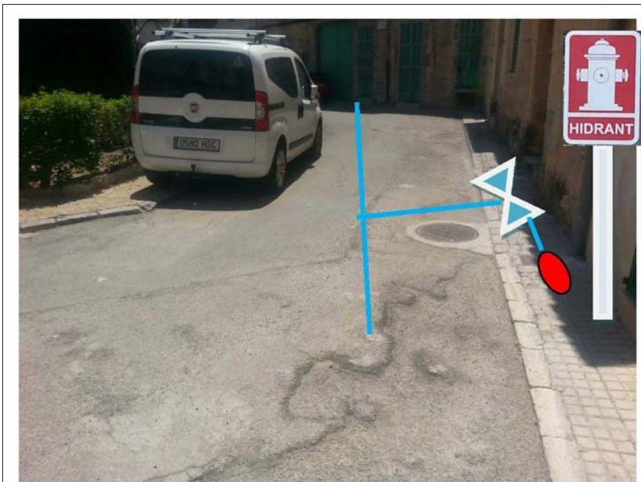
HIDRANTS Nº 3 (Traslata a l'acera, senyal a la vora de la paret)
