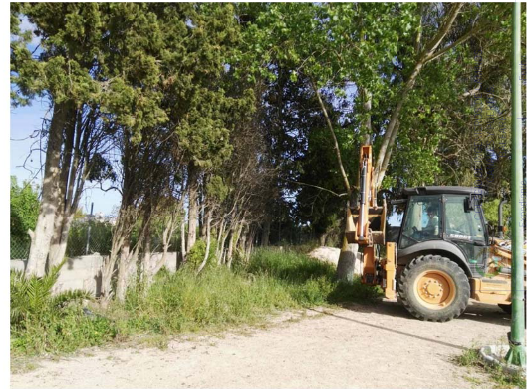
FOTO 13: Vista parcial de la zona d'estudi de la cata 1
