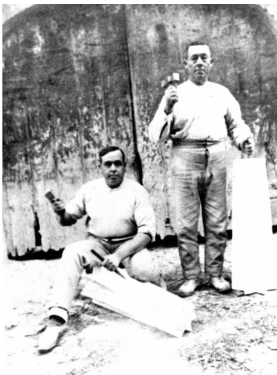
Figura 4. Obrador de cals Ferrans al carrer del Vent.
